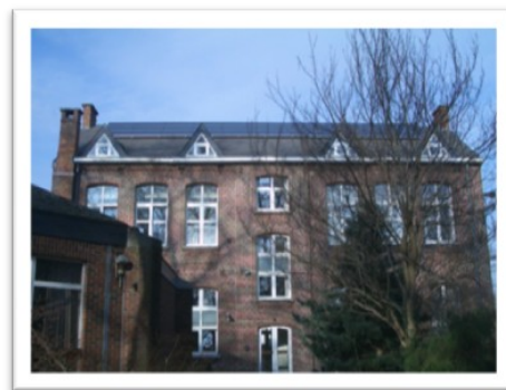
Panneaux photovoltaïques installés sur la toiture arrière du bâtiment
